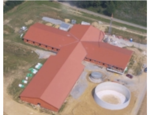
Luftaufnahme des neuen Stalles während der Bauphase
