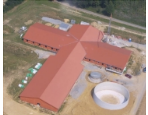
Luftaufnahme des neuen Stalles während der Bauphase
